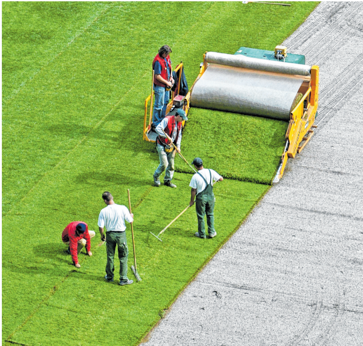
Sache für Experten: Im Fußballstadion wird Rollrasen verlegt.
